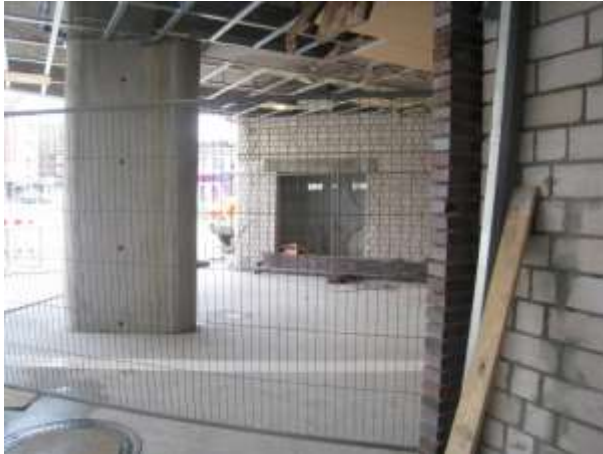
Abb. 46: Eingangsbereich bei vorläufiger Öffnung
