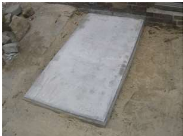
Abb. 49: Treppenfundamente
