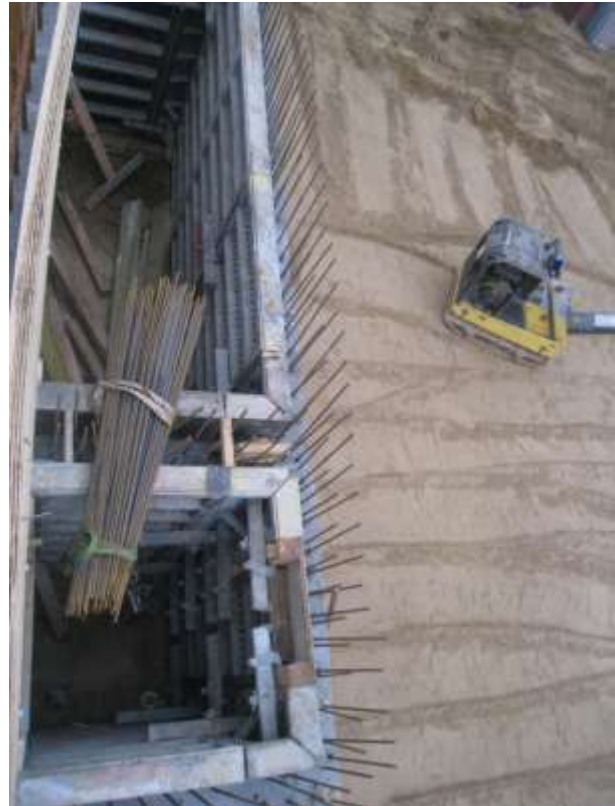
Abb. 40: Anschlusseisen des Lichtschachts
