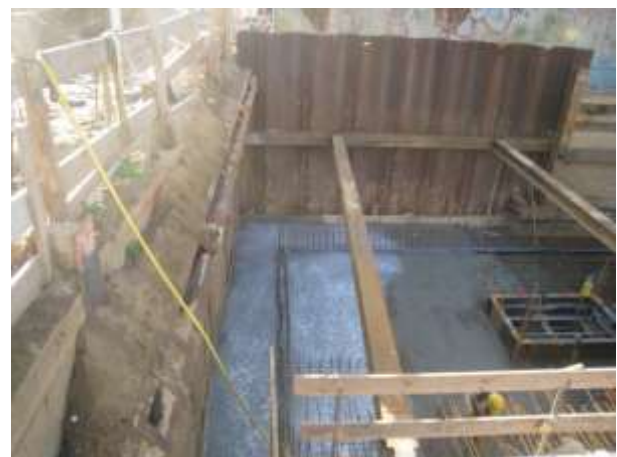
Abb. 25: Betonieren der Fundamentplatte
