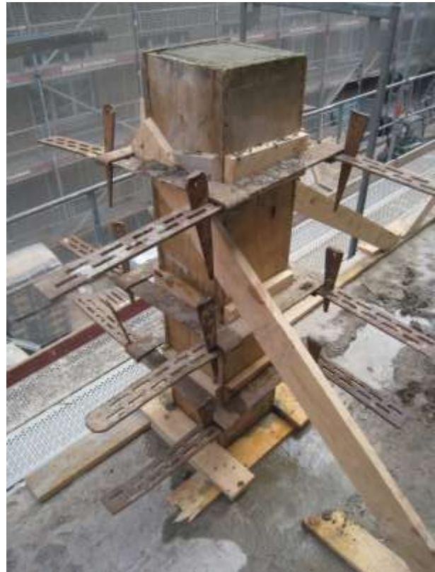
Abb. 51: Gesicherte Stützenschalung
