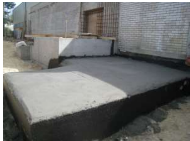
Abb. 55: Unterbeton mit Gefälle
