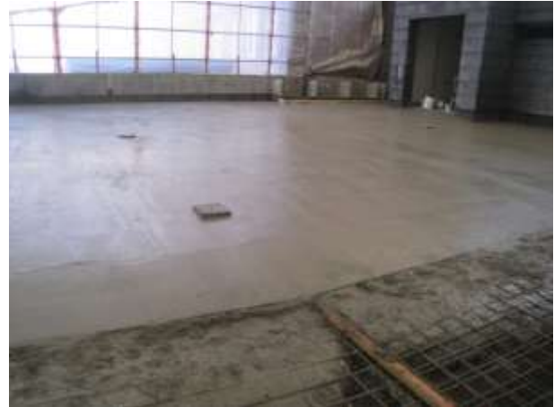
Abb. 47: Betonierete und abgezogene Fläche
