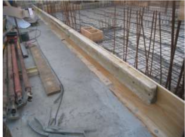
Abb. 44: Randschalung auf der Decke
