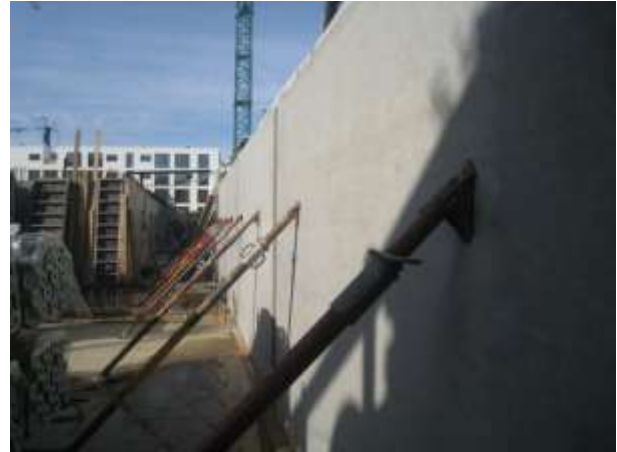
Abb. 19: Abgestützte Sandwichwand
