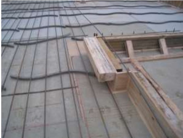
Abb. 41: Konsolenaufleger für die Treppe
