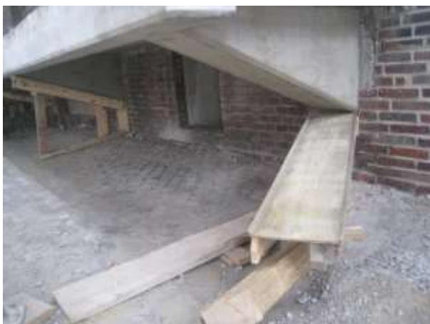
Abb. 48: Schalung der Laderampe
