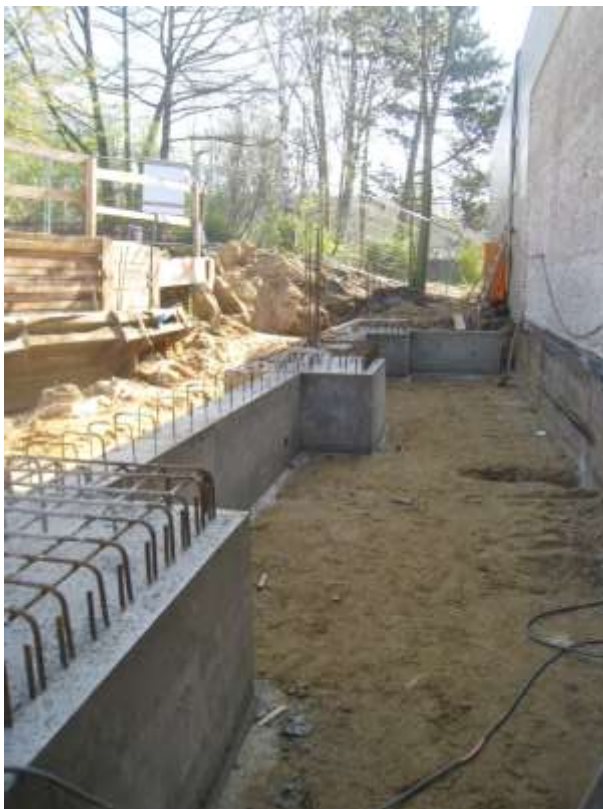
Abb. 52: Fundamente Aufzugsgebäude
