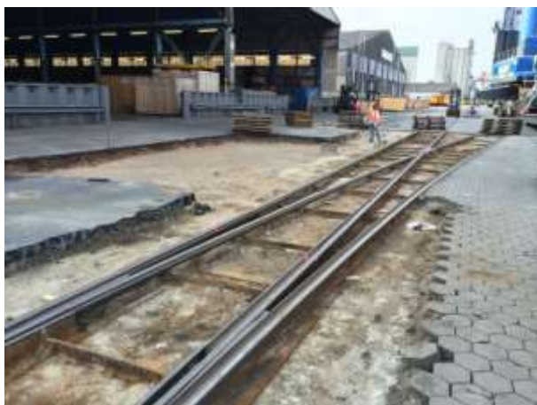
Abb. 5: Ausgekofferte Fläche
