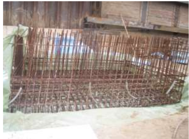
Abb. 21: Bewehrungskorb des Fahrstuhlschachts
