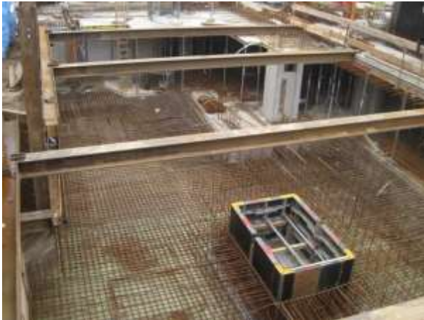
Abb. 22: Bewehrung der Fundamentplatte
