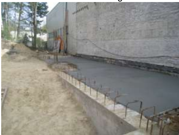
Abb. 54: Unterbeton zwischen den Fundamenten
