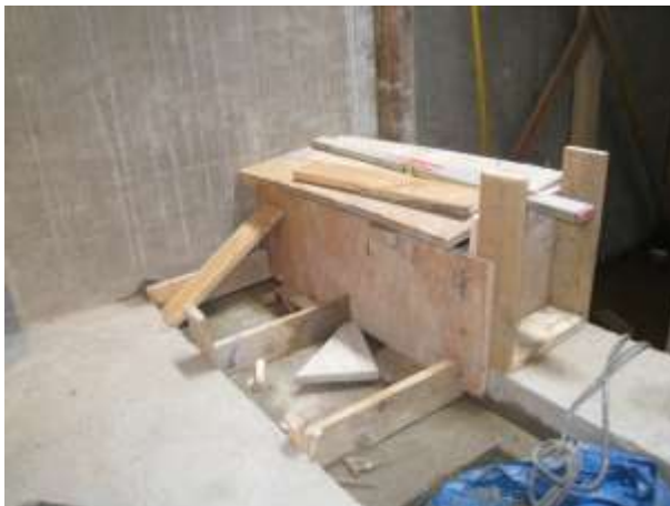
Abb. 56: Eingeschalte Betonsockel
