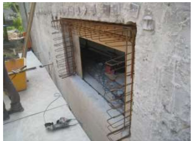
Abb. 57: Bewehrungskorb des Durchbruchs
