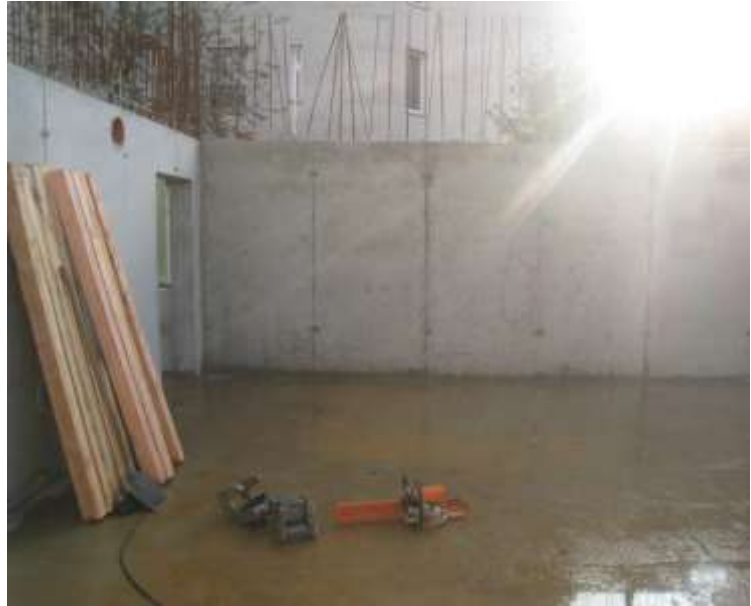
Abb. 31: Ausgeschaltete Stahlbetonwand
