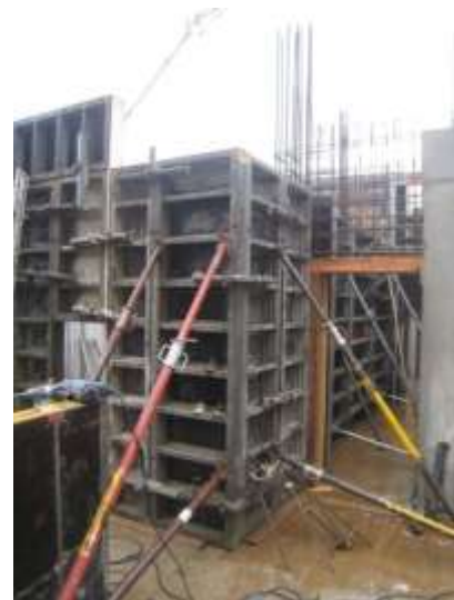
Abb. 34: Schalungssicherung
