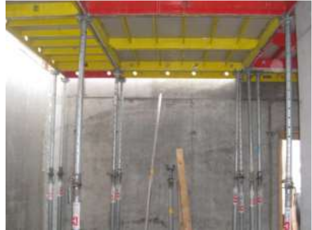
Abb. 38: Aufgestellte Schalung
