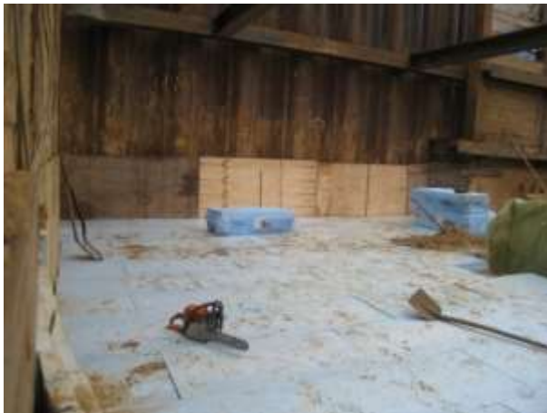
Abb. 20: Ausgelegte Sohlämmung
