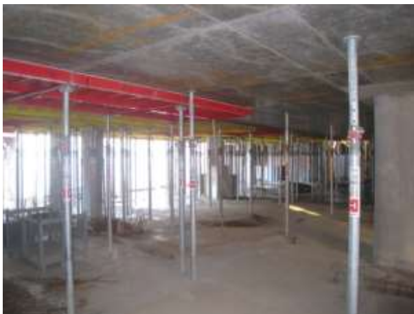
Abb. 35: Teilweise ausgeschalte Decke
