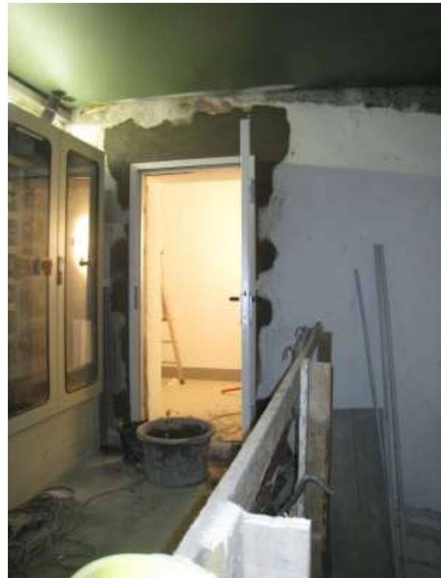
Abb. 53: Eingebaute Durchgangstür
