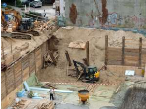
Abb. 15: Eingestürzte Baugrube
