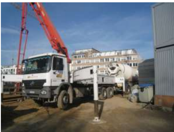
Abb. 24: Betonpumpe
