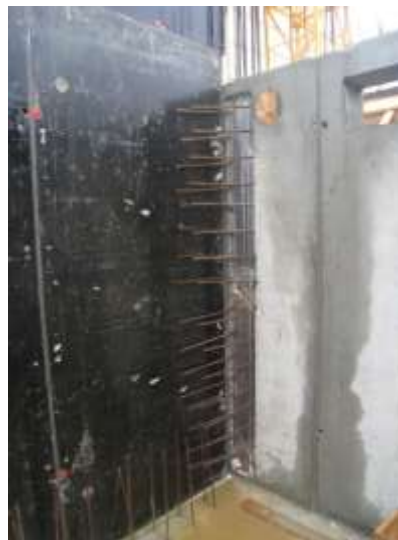
Abb. 33: Anschlussbewehrung
