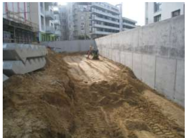
Abb. 27: Einbau des Bodenmaterials
