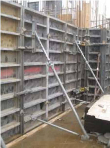
Abb. 30: Schalungssicherung
