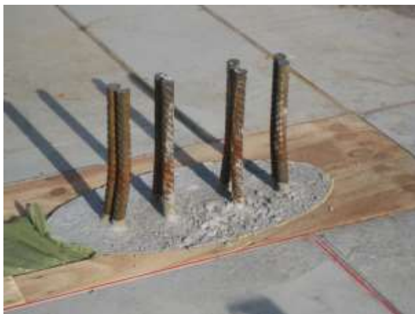
Abb. 26: Stützenbewehrung
