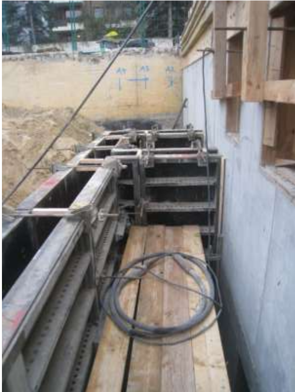
Abb. 39: Absturzsicherung des Lichtschachts
