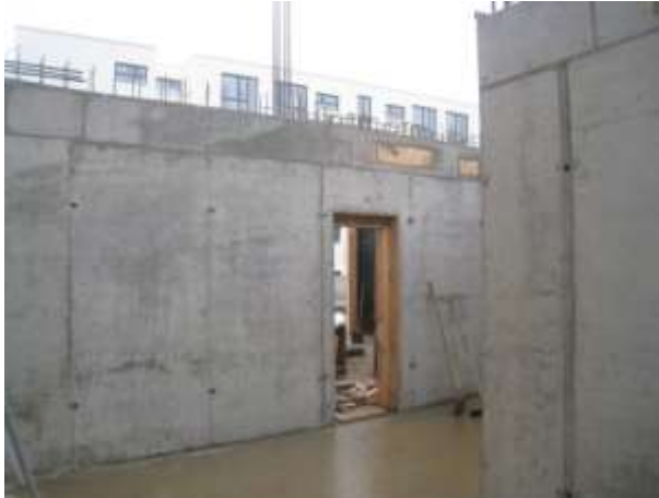
Abb. 37: Leerer Raum in Haus 35
