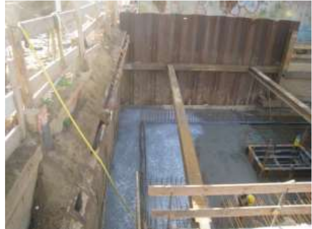
Abb. 16: Spundwandverbau mit Stahlträgern
