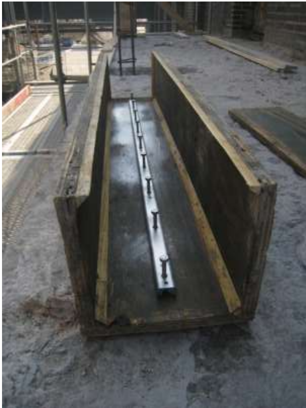
Abb. 50: Stützenschalung mit Ankerschiene
